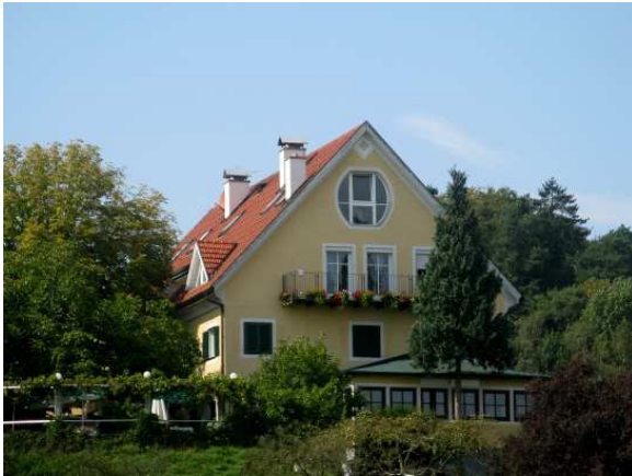
Umbau des Restaurants 1993
