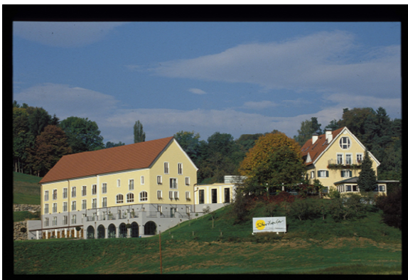
Hotelbau 2000/1 – Eröffnung 1. Juli 2001
