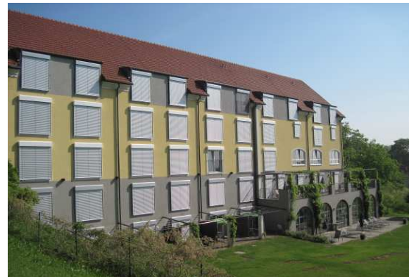
Ausbau des Dachgeschoßes 2009
